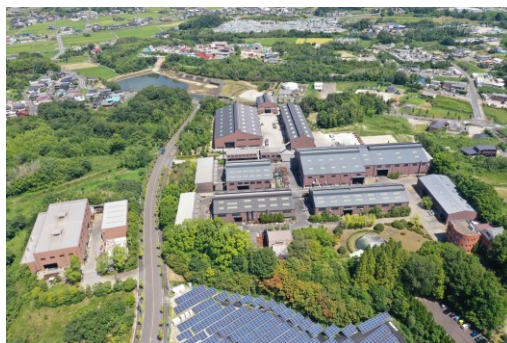
(中村鉄工所 工場外観)
